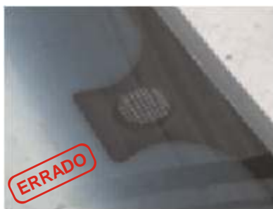
Local da colagem da pastilha raspado em xadrex.
